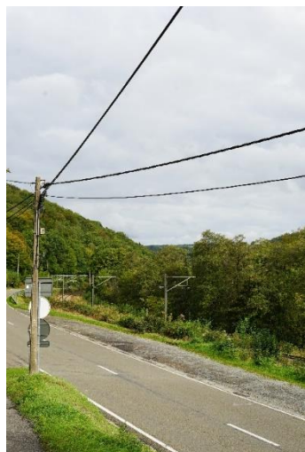
Photo 84 N633 et voie ferrée dans la vallée de l'Amblève
