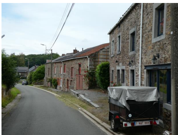
Photo 37 Paradis Date de prise de vue : 24/07/2020
