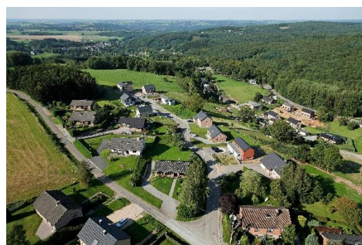
Photo 59 Bâti en ruban Source : Commune d'Aywaille
