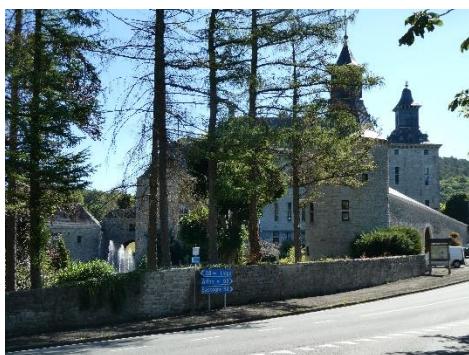
Photo 56 Château de Harzé Date de prise de vue : 23/07/2020
