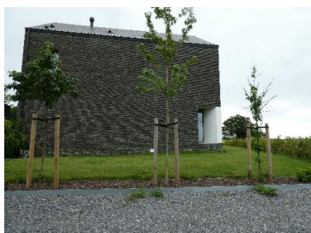
Photo 60 Maison contemporaine à Faweux Date de prise de vue : 23/07/2020
