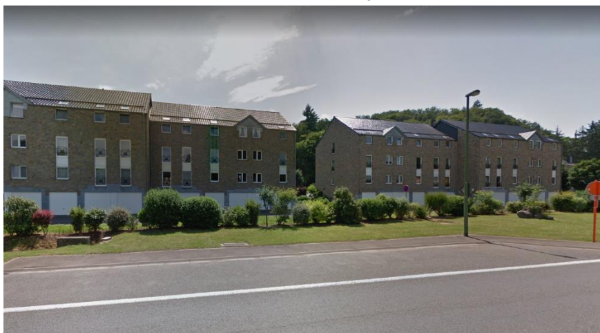
Photo 72 Ensemble collectif à Sougné-Remouchamps Source : Google Maps
